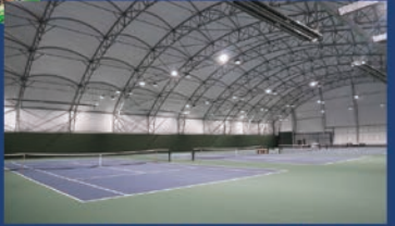
Kapalı Saha Aydınlatması
